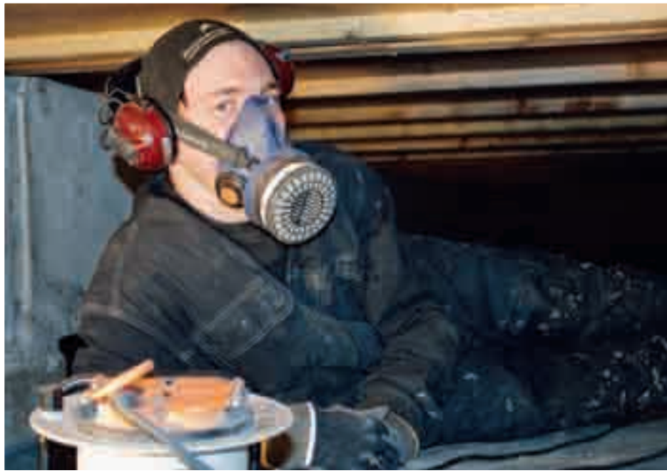
Andreas Warranperä borrar hål i trossbotten. Detta görs bland annat för att få ner spillvärmern från huset till krypgrunden.
