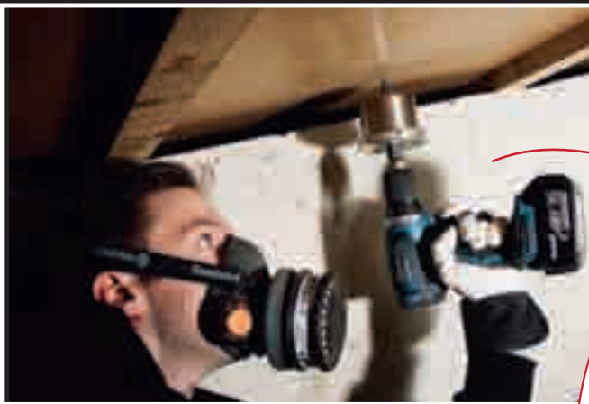
Andreas Warranperä borrar hål i trossbotten. Detta görs bland annat för att få ner spillvärmern från huset till krypgrunden.
