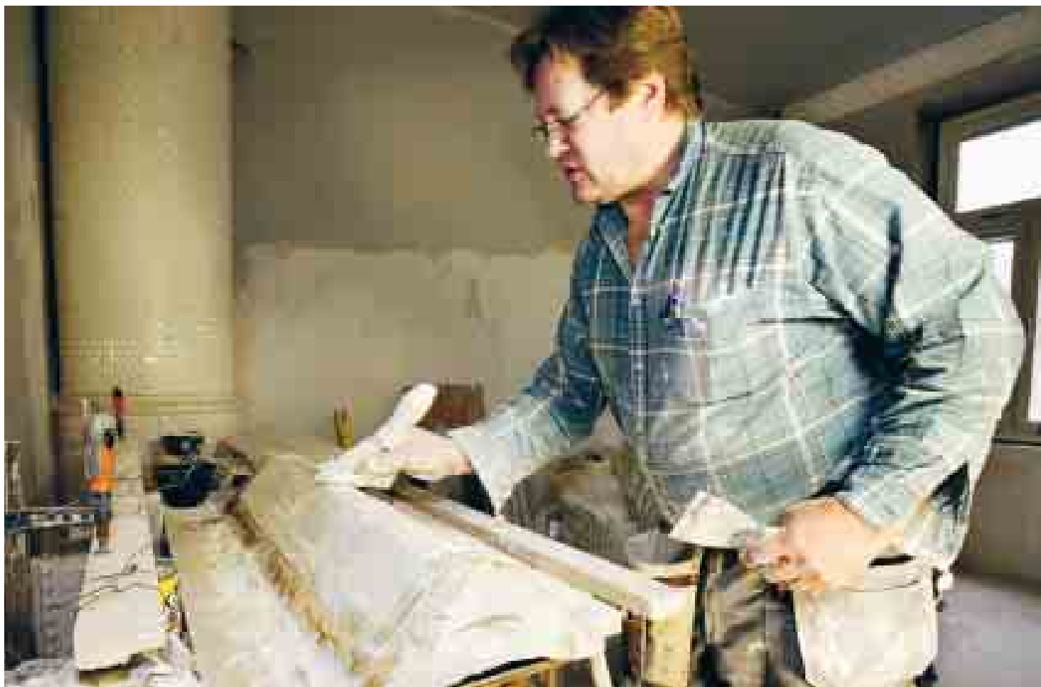
Johnny måste hålla ett högt tempo när han fyller formen. Efter 20 minuter har gipset stelnat och blivit obrukbart.
