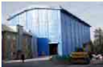
Fabriksfärdiga lägenheter monterades i stora tält på bygget.
