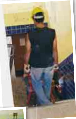
Arbetare har släpat sten på presenningar och tagit rivmaterial mellan våningarna med vanliga skottkärror.
