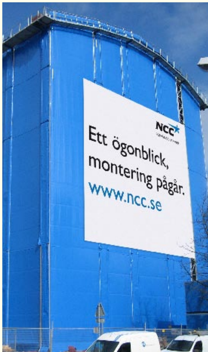
Byggnads kräver bygglöner när NCC bygger på löpande band, här i Eskilstuna. Men NCC har redan tecknat avtal med IF-Metall.
