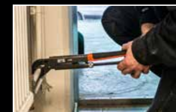
Nära 50 procent av rörmokarna arbetar på ackord.
