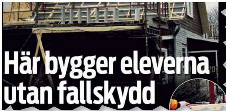
Byggnadsarbetaren nr 9, 2011. Ett elevbygge i skolregi utanför Vara.
