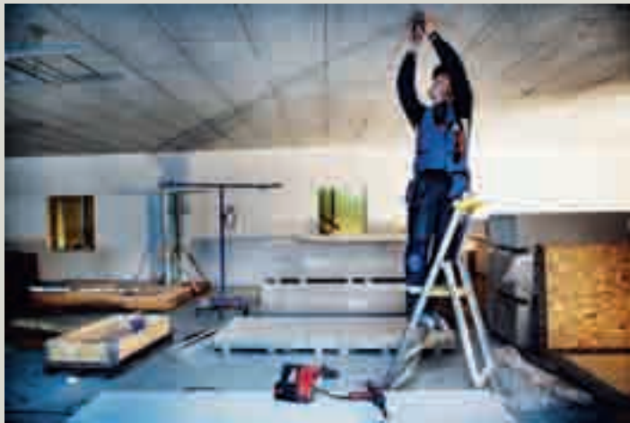
I personalgaraget håller installatörerna på att montera sprinklers och dra el.
