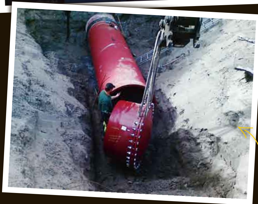
MATS ERIKSSON: "Utbyggnad av reningsverk. Tomas försöker att montera proppen i ändan. Diameter på röret är 150 centimeter om inte mitt minne sviker. Varje pipa väger 6 ton och har en längd på 8 meter."
