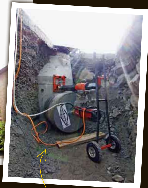
PER-ERIK NYBÄCK: "Ett dräneringshål i Arlandaskogen där det byggs nya terminaler åt Arlanda Cargo City. Borr motorn orkade utan problem, som här, dra runt en 700 mm borrhörl. Alltså inga problem med alltför kraftiga vibrationer, då en 12 mm expanderhylsa/slagankare höll hela riggningen i en bara 15–16 cm tjock brunnsring! Kärnan fick vi dock inte upp ur gropen på två man, utan vi fick tillkalla en lastare med gafflar sedan vi stropat borrhörlkärnan."
