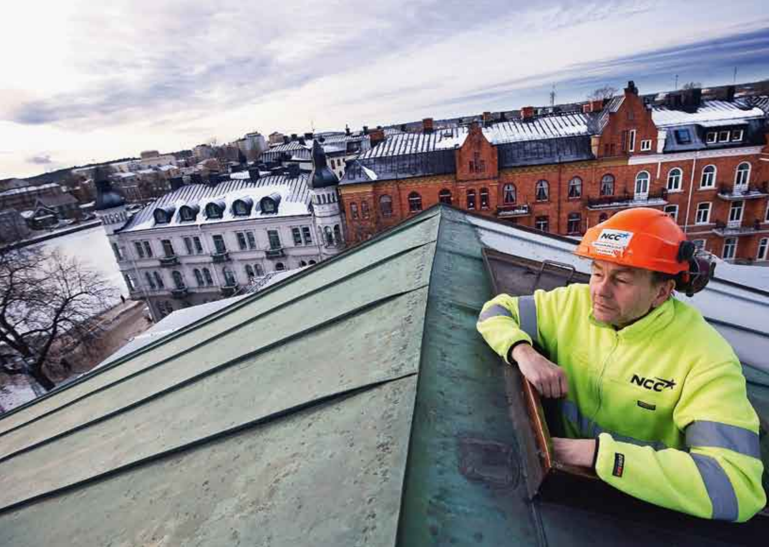
Karlstad teater ligger centralt i staden, precis intill Klarälven. Snickaren Ronald Johansson tycker att det har varit speciellt att bygga ut teatern. Det har varit ganska rörigt och en hel del ändringar under byggets gång.
