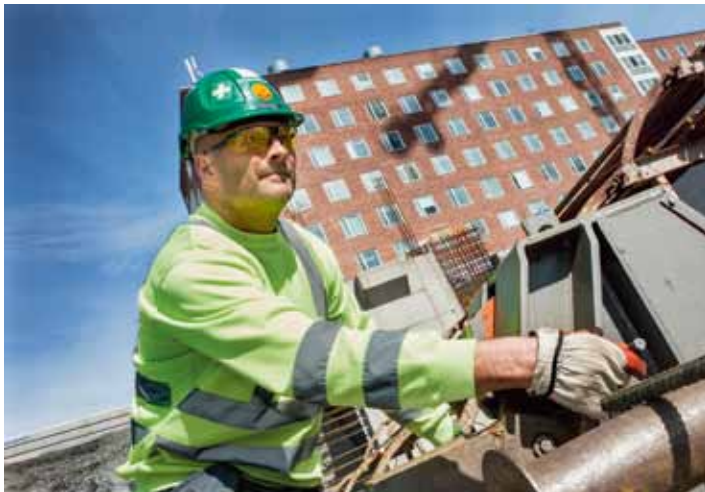
Rikard Andersson kapar armeringsjärn. Glasögonen skyddar mot hoppande metallflis.
