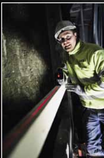
Erik Andersson står i en mörk vrå och markerar borrhål med hjälp av en laser.
