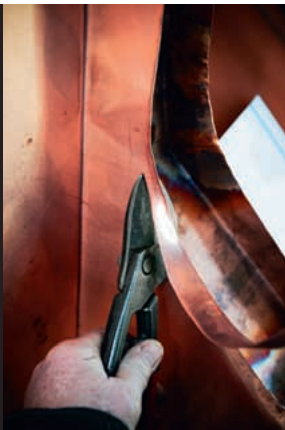
En sax för varje behov: Till vänster klipper Mats Larsson en vid högervälg med fasonsaxen. På övre bilden till höger en snäv vänstersvälg med krumsaxen. Och så till sist klipper han rakt med takplåtsaxen.
