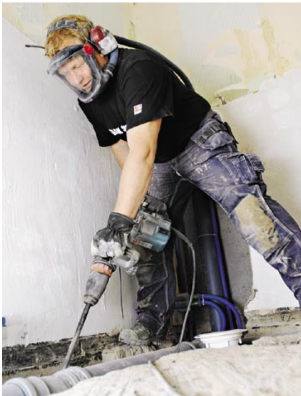
Christer Larsson på Olofssons Bygg i Borås går loss med bilningsmaskinen i ett badrum från miljonprojektets dagar. Byggnadsarbetarens test visar att bilningsmaskinen fortfarande är ett mycket farligt verktyg.
