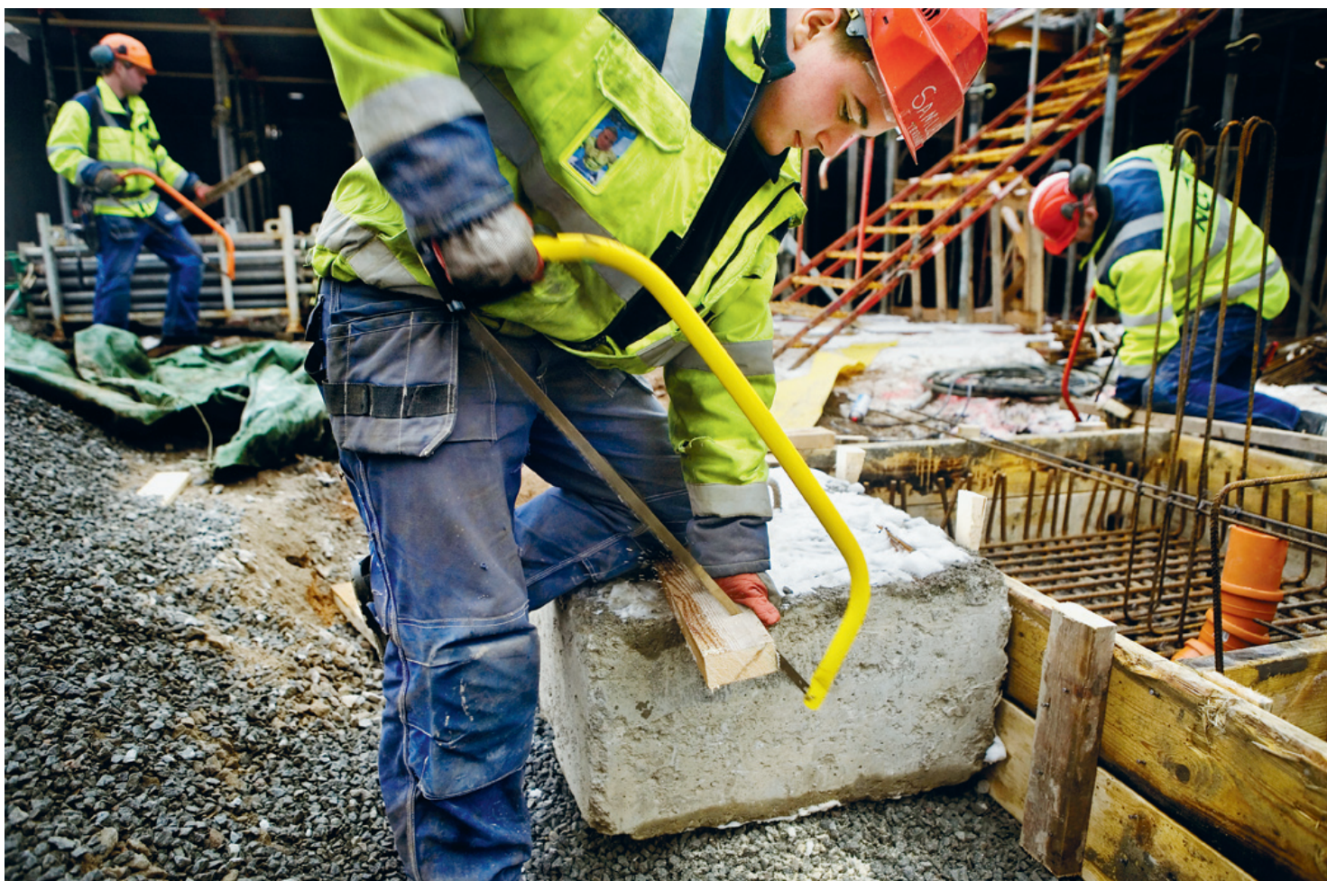
Bland de yngre används bågsågen mest till att såga av regler. Samuel Tervanen provar Ironsides såg som fick betyget två i testet.
