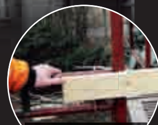
Snören och en bräda håller ihop ett trappstorn med ställningen.
