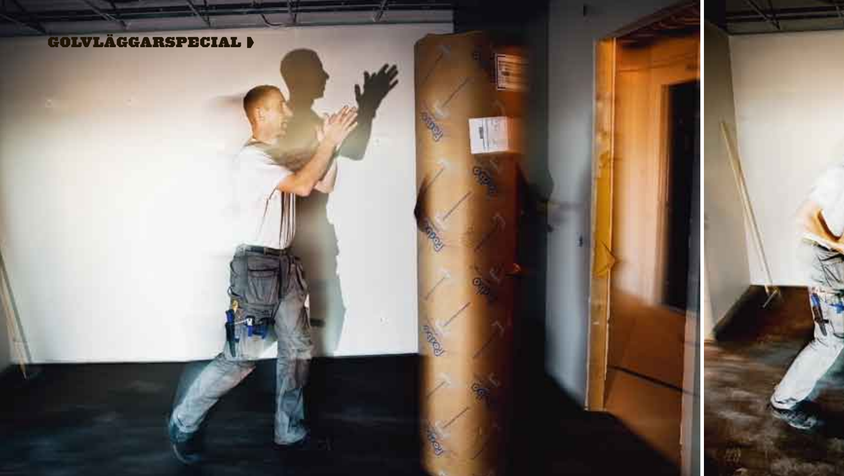
Claes Pettersson fäller en linoleum-mattrolle. Rullen är 32 meter lång och väger 270 kilo. Den fyra millimeter tjocka mattan består främst av kork, vilket ger en ljuddämpande effekt.
