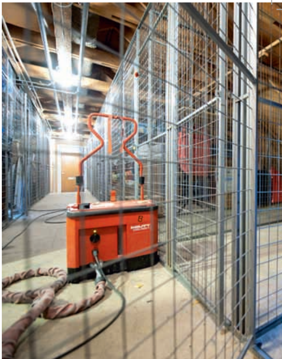
Håltagaren Sören Svensson borrar där varmvattnet ska ledas ner från växlarna på vinden. Det är viktigt att borrarädet flyter på, annars riskerar arbetet att stanna av.
