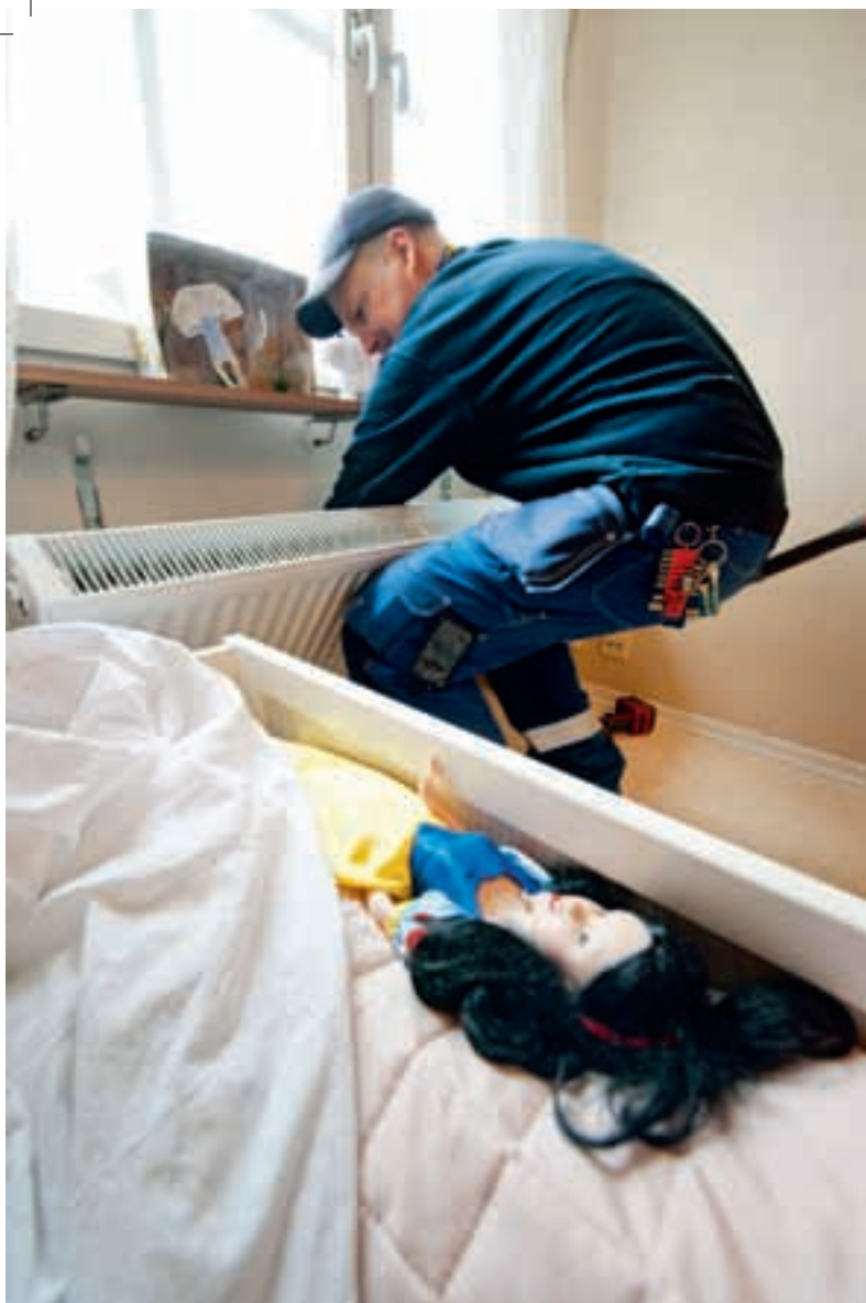
Byggarbetsplats på dagen. Men efter fem ska barnen kunna leka i sina rum igen. Inga verktyg eller smuts får lämnas kvar.
