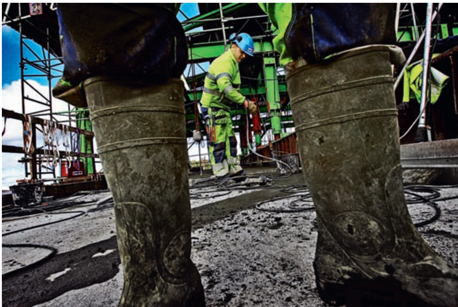
Anläggningsarbetarna, som bygger en bro i norra Bohuslän, har fullt upp. Just nu är det högkonjunktur för väg- och järnvägsbyggen i Sverige.
