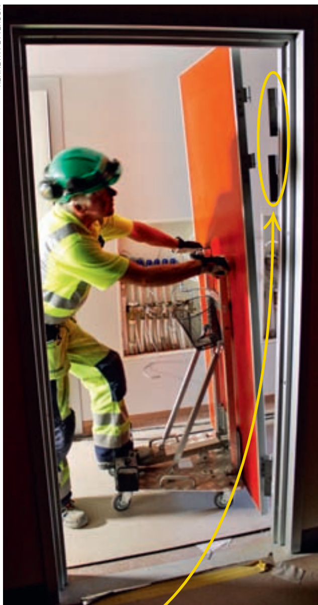
Med lyften kan Rolf Sjögren ensam montera tunga dörrar. Med hjälp av styrblecken på karmens gångjärn kommer dörren rätt.
