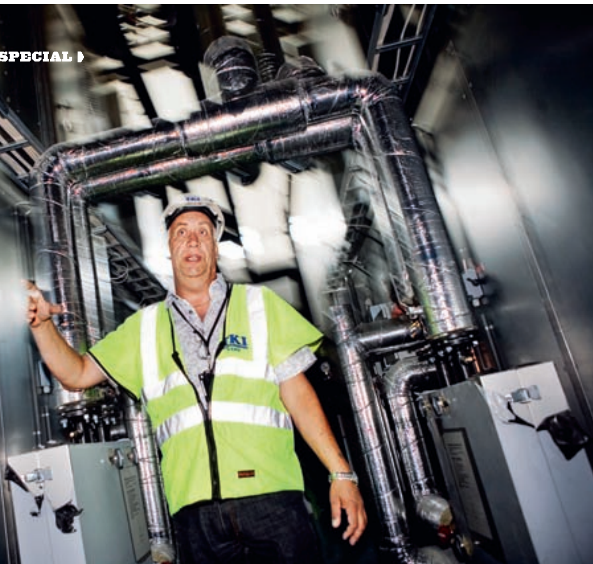
Ventilationen har stått i centrum vid byggandet av forskningshusen vid Karolinska institutet. Arbetsledaren Anders Aronsson, med 35 års erfarenhet i yrket, har aldrig varit på ett sådant stort ventilationsbygge inom laborievärlden tidigare.
