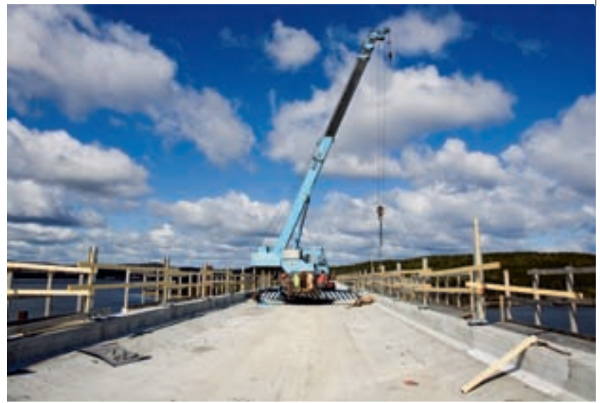
Nu rivs formarna vid den färdiggjutna järnvägsbron.
