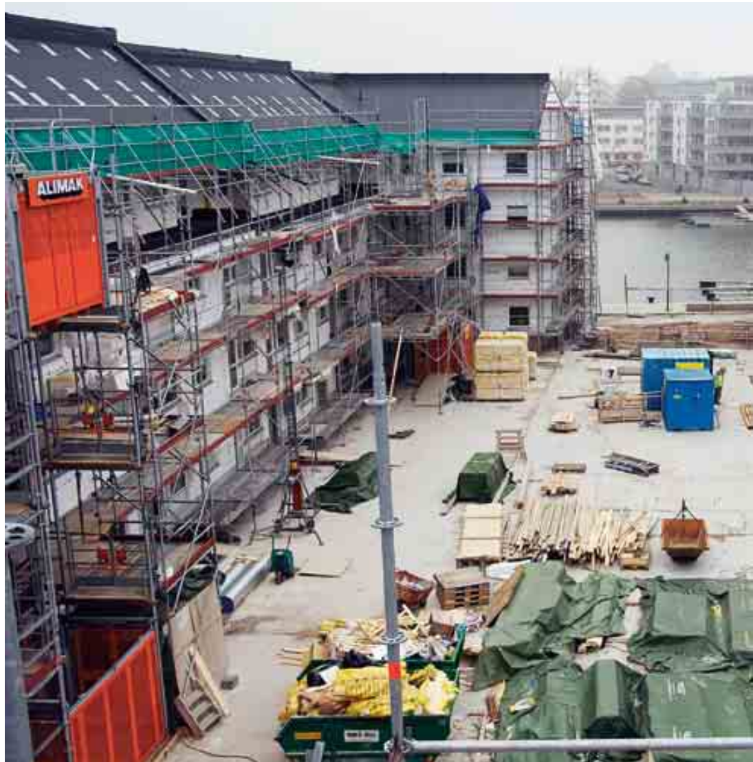
Hamnhuset på Hisingen i Göteborg består av 115 lägenheter. I augusti ska bygget vara klart.
