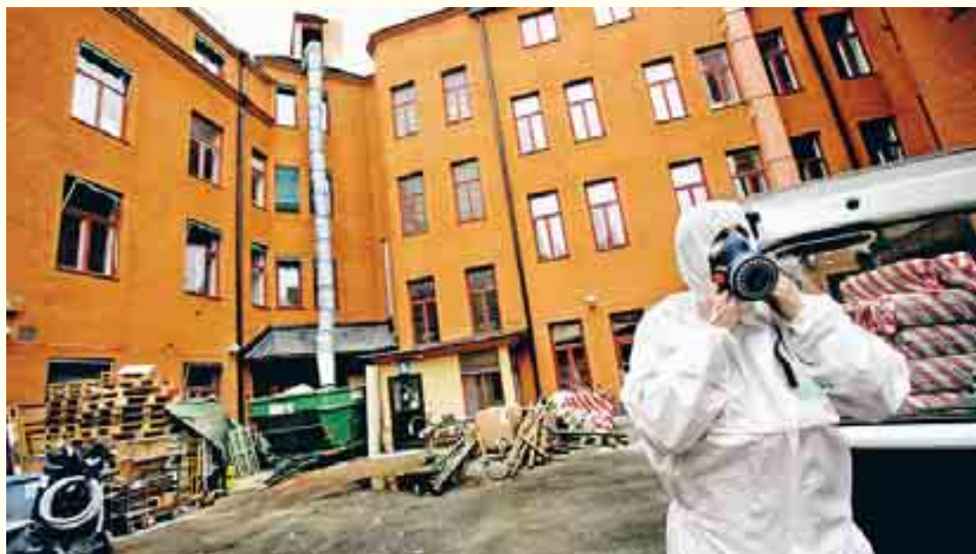
Här på Plaza hotell i Örebro utsattes byggnadsarbetarna för asbest, nu riskerar byggherren vite.
