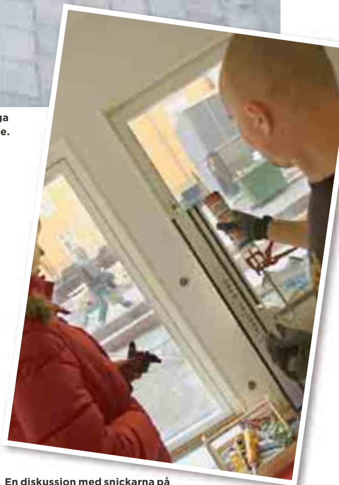
En diskussion med snickarna på bygget uppstår när Mia Torpe upptäcker en tub silikon med farligt innehåll.
