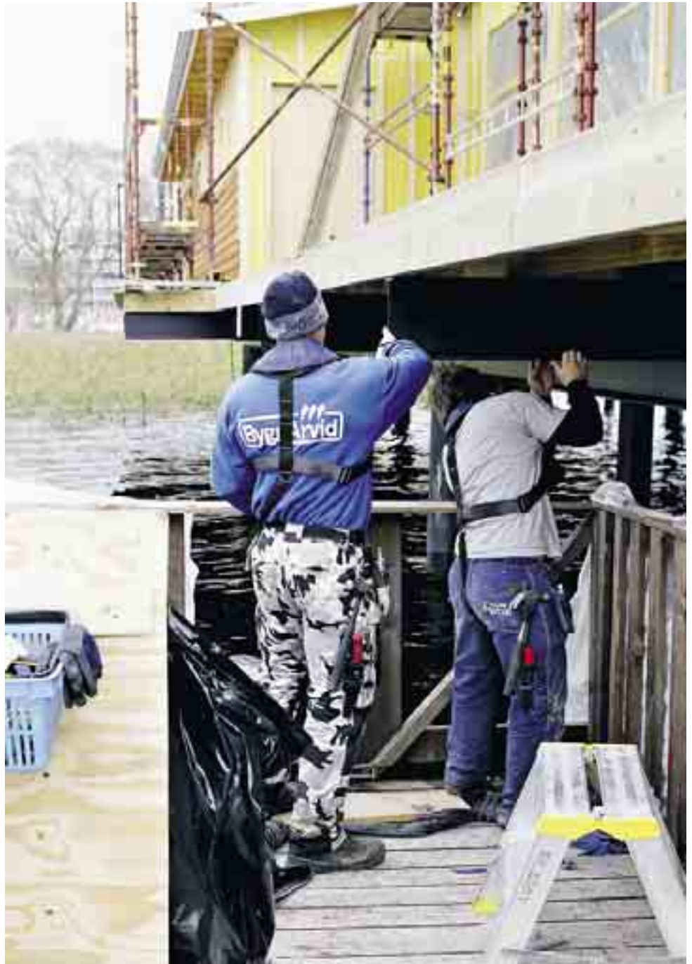
Den 1,5 meter breda gångplattformen runt badhuset var från början inte planerad utan kom till för att byggställningarna skulle ha någonstans att stå.
