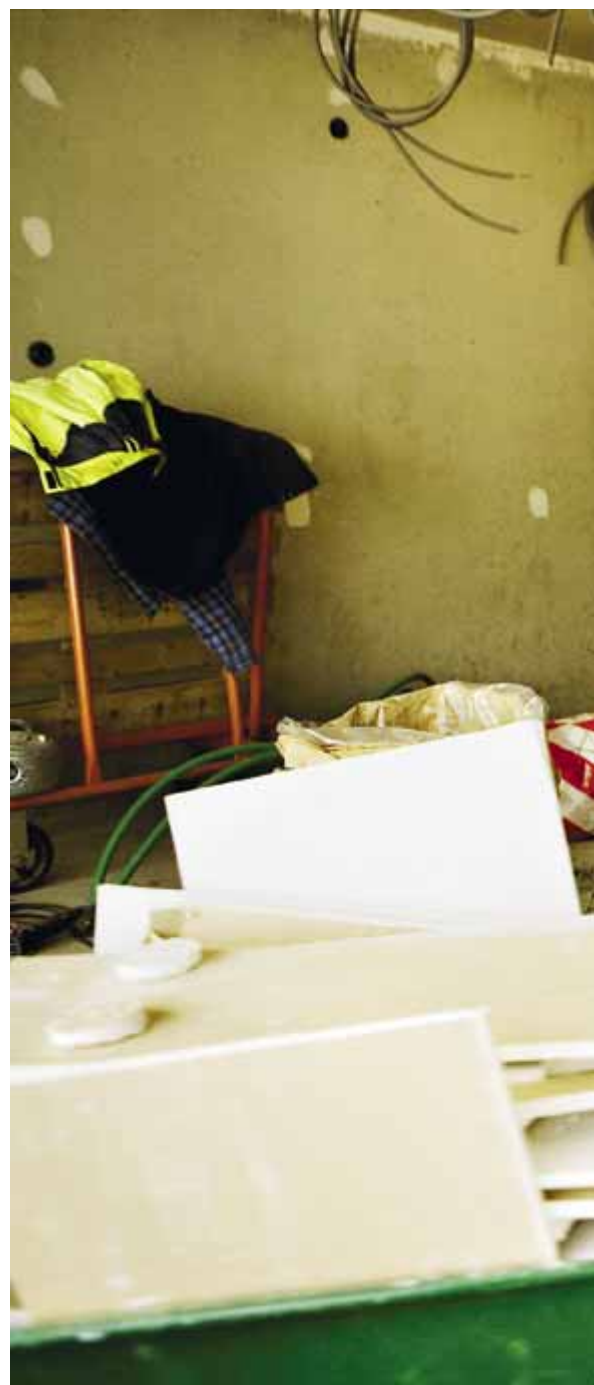
Att sortera byggavfallet är bra för miljön, det sänker pengar, men en positiv bieffekt blir att vi hjälper till
