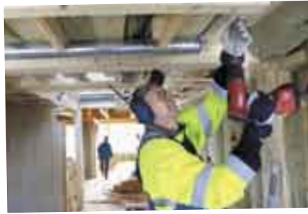
Mats Karlsson lossar skruv i bjälklaget på sjätte våningen.
