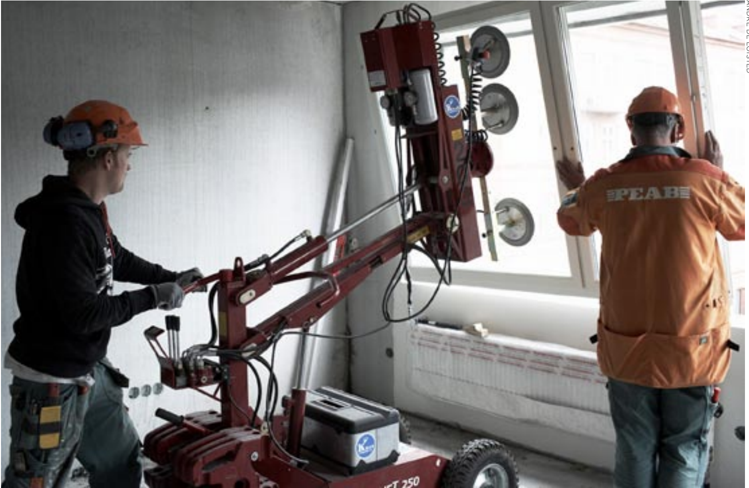
Glasliften, som Patrik Persson använder, kan rullas genom en dörröppning som är 68 centimeter bred. Den klarar upp till 250 kilos last.
