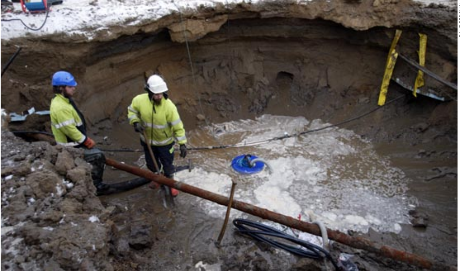
Jan-Olof Staaf och Henke Sjödin från MittSverige Vatten byter vattenledning utanför Sundsvall. Böjslangen ökar vattenflödet från pumpen.
