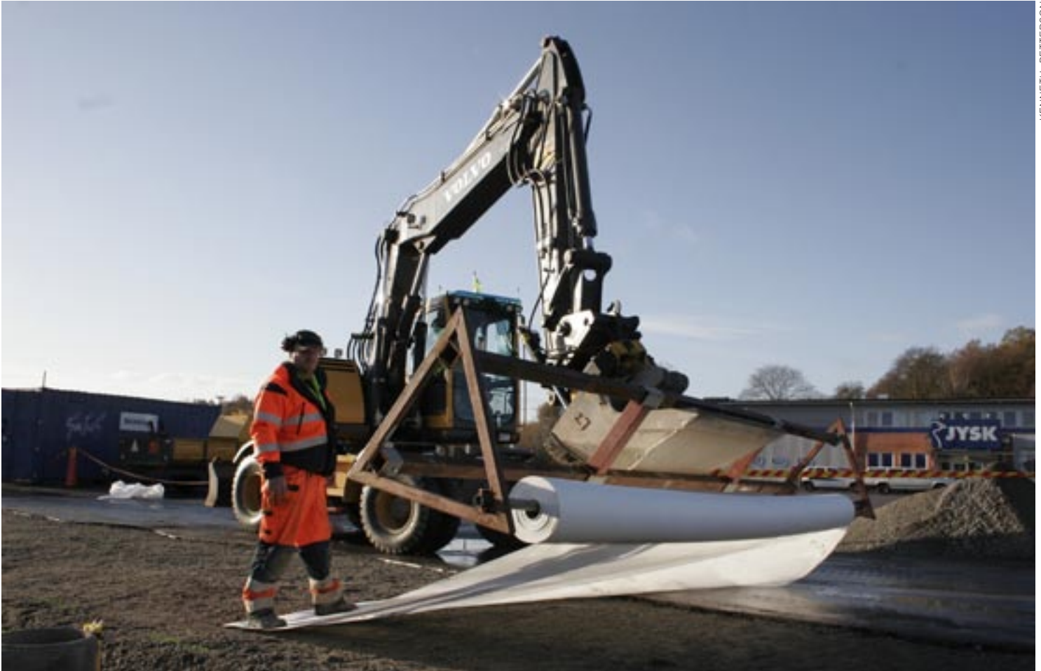
Markanläggaren Magnus Södling tar hjälp av maskinföraren Tommy Johansson när markduken rullas ut.
