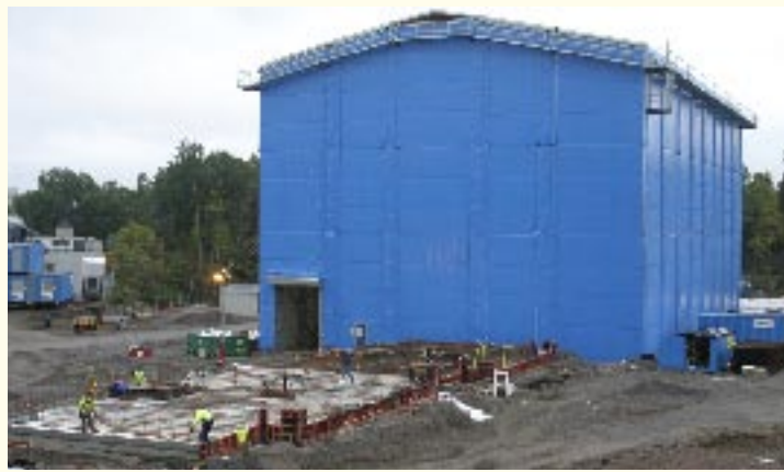
I Sundbyberg utanför Stockholm bygger NCC 48 lägenheter. Husen tillverkas på fabrik och sätts ihop i stora tält på byggplatsen.
