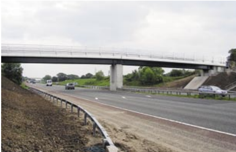
Bron över M6 i norra England är byggd av glasfiberarmerad plast. Endast de bärande bjälkarna är av stål.
