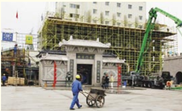
Hitresta byggnadsarbetare från Kina förvandlar Hotell Älvkarlen söder om Gävle till ett kinesiskt center.
