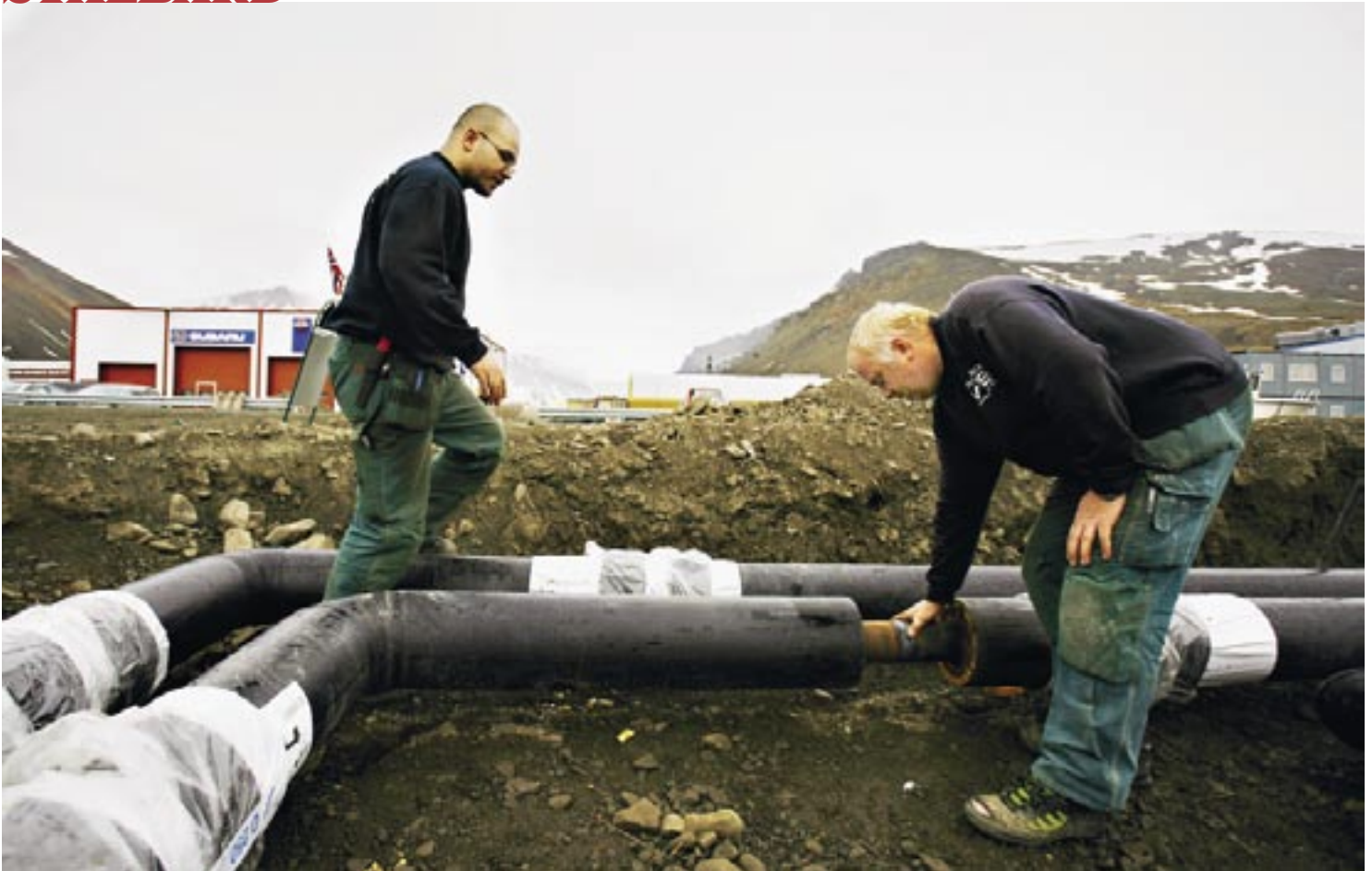
Michael Olnils och hans kollega Kim Rune Ness kontrollerar att värmen är tillräcklig vid ledningarna. Tidigare har alla ledningar på Svalbard dragits ovan jord men sedan några år gräver man ner dem.
