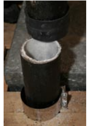
Ulf Larssons specialfräs påminner en om stor tandläkarbör och fjärrstyrs via en monitor på upp till 15 meter från arbetsstället. Fräsen klarar 90-graders rörvinklar. Från vindsvåningen arbetar Ingemar Magnusson med att ge rören nytt innerhölje av epoxi.
