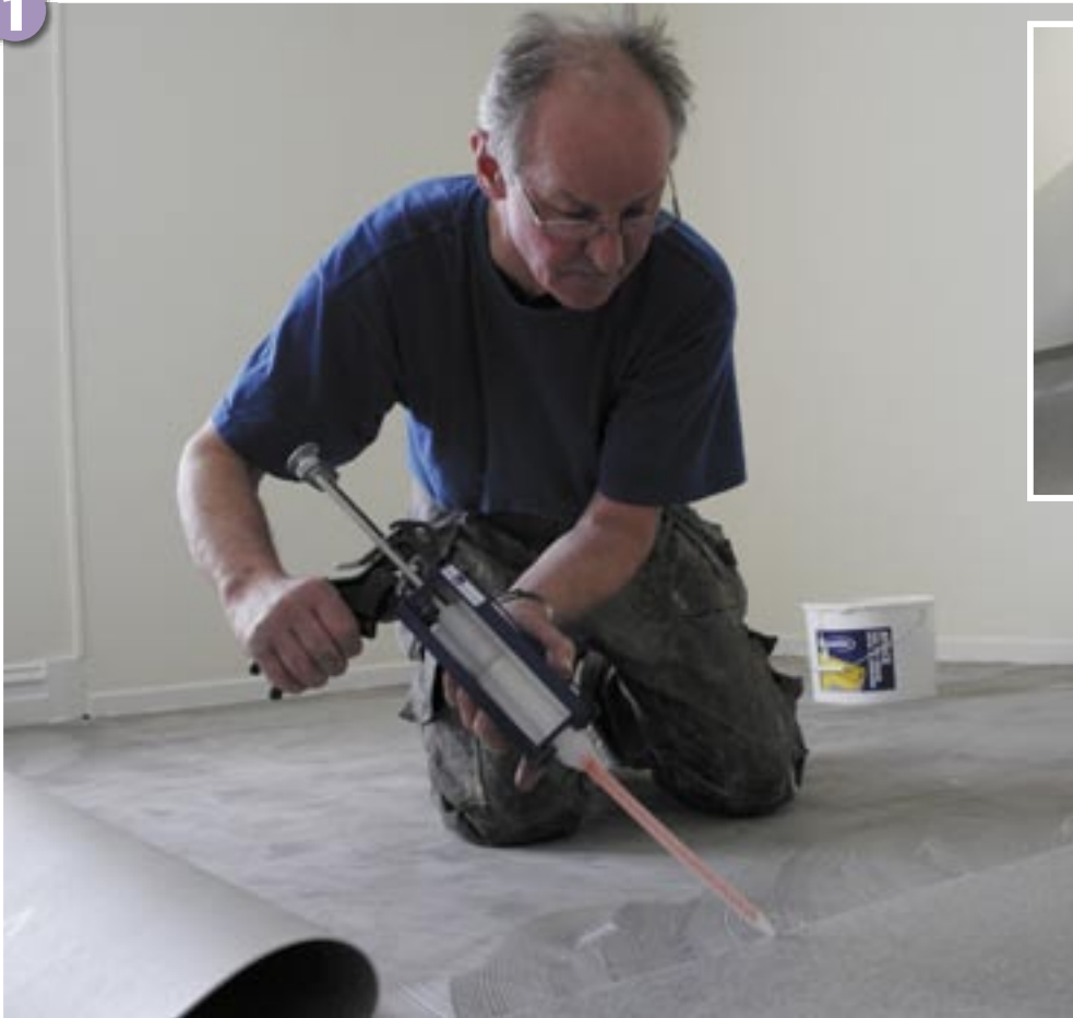
Med en tandemfogpruta lägger Rolf Danielsson en rejäl sträng tätmedel längs skarven. Tvåkomponentslimmet fungerar som kemsvets, men luktar inte.
