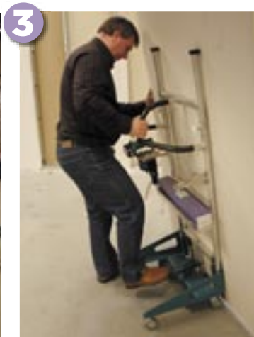
1. Vagnen fälls upp så att gipslasten går igenom en dörröppning. 2. Skivorna tippas över på en kassettvagn och placeras i rätt läge för monteringen. 3. I trånga utrymmen används en monteringsvagn. 4. Monteringsroboten styrs med joystick-spakar och klarar höjder upp till 3,6 meter.
