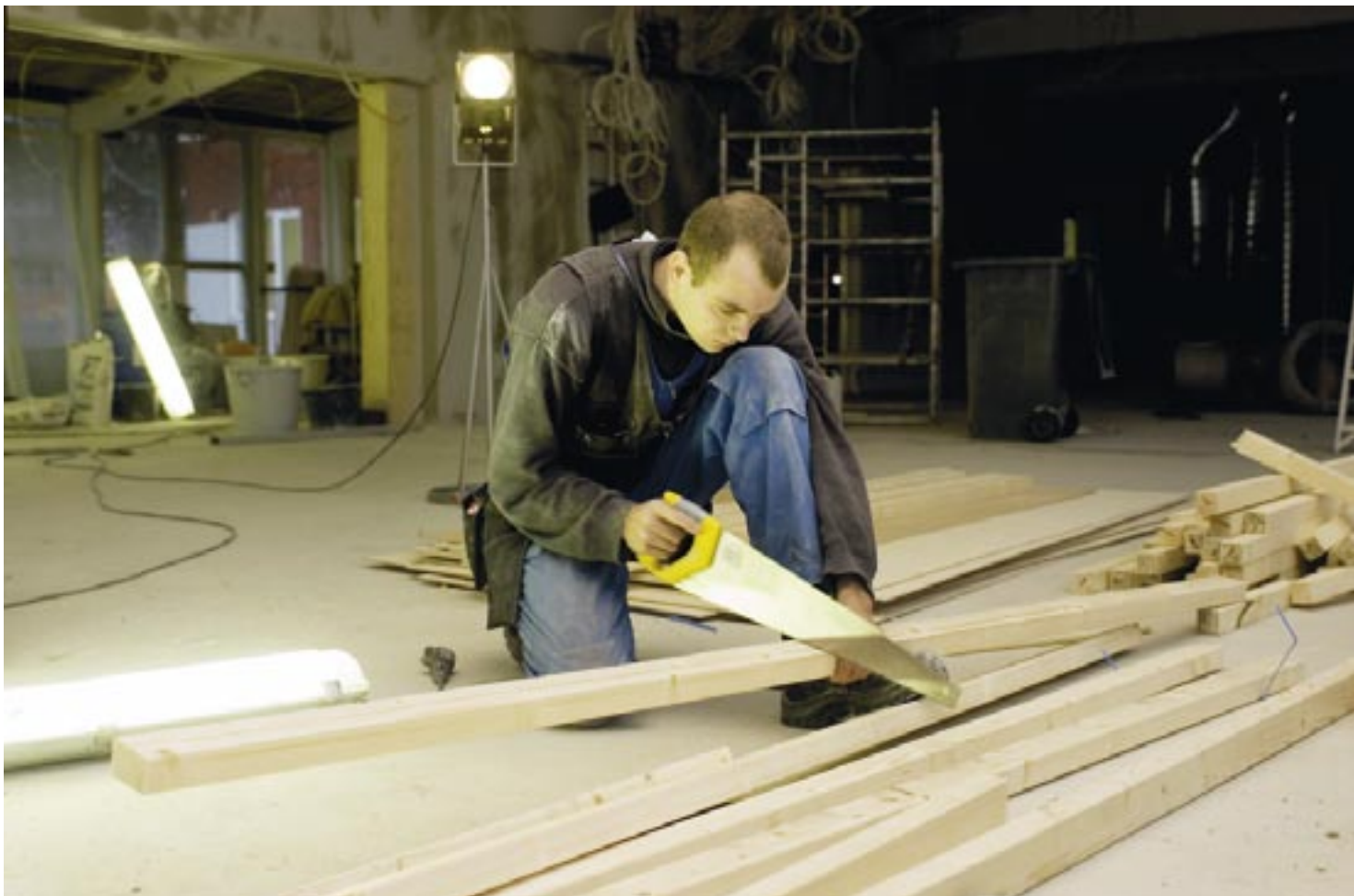
Jaris Riives från Estland arbetar på ett Peab-bygge i Helsingfors som undertagsmontör. Han hyrs ut av en finskägda firma i Estland. Jaris Riives arbetsgivare är ett av alla de finskägda företag som etablerat sig i Estland under senare år.
