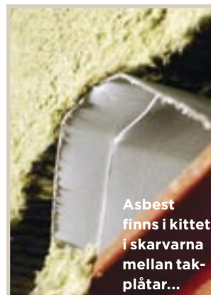
... i tätningskitt till ventilationsrör...
