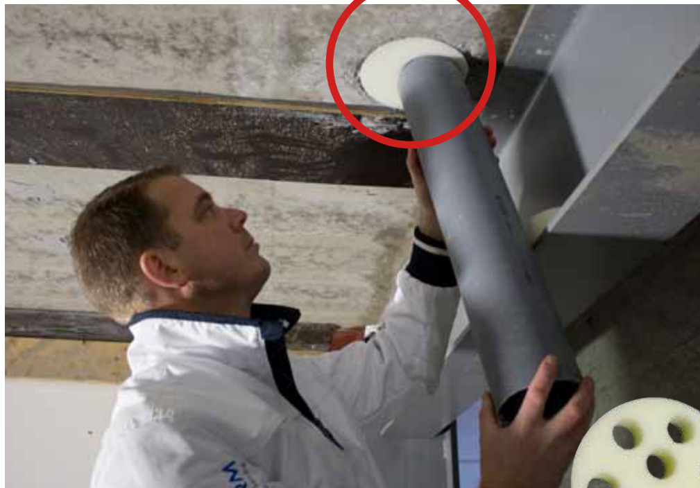
Betongarbetaren Andreas Uppgren visar skumgummikudden som används för att tätta rör. Den finns i olika utföranden beroende på rörets dimension.
