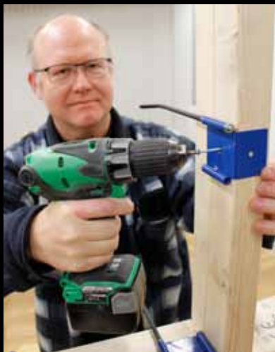
Konsolen hindrar att fönstret faller utåt under monteringen.
