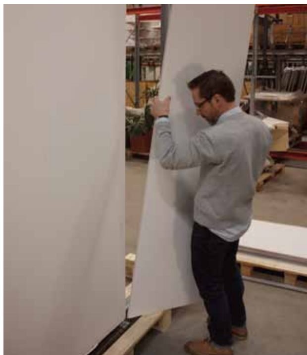
Peter Lindberg har utvecklat väggssystemet Oneday Wall. Det består av gipsskivor som träns i varandra som ett klickgolv. Den första skivan placeras i en startskena (övre bilden till höger).
