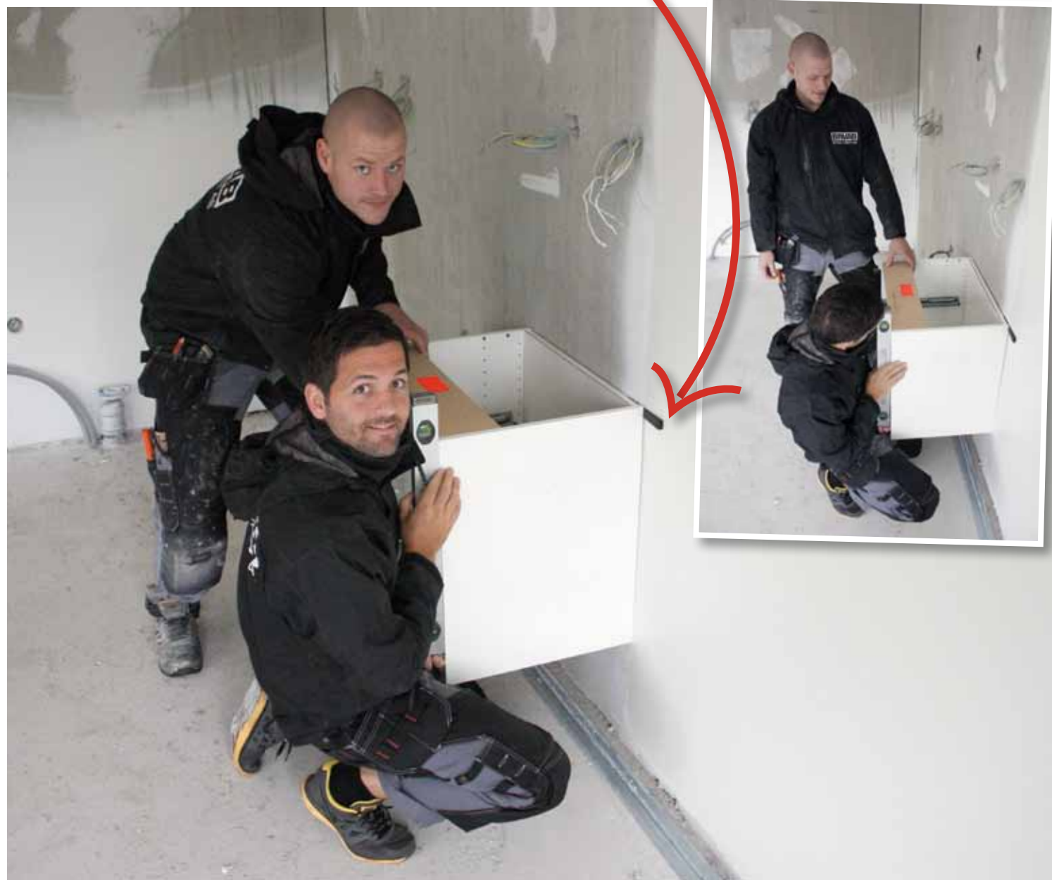
Robin Antonsson och Fredrik Söderberg fick idén till brytkilen bakom skåpstommen samtidigt som den riktas med hjälp av
