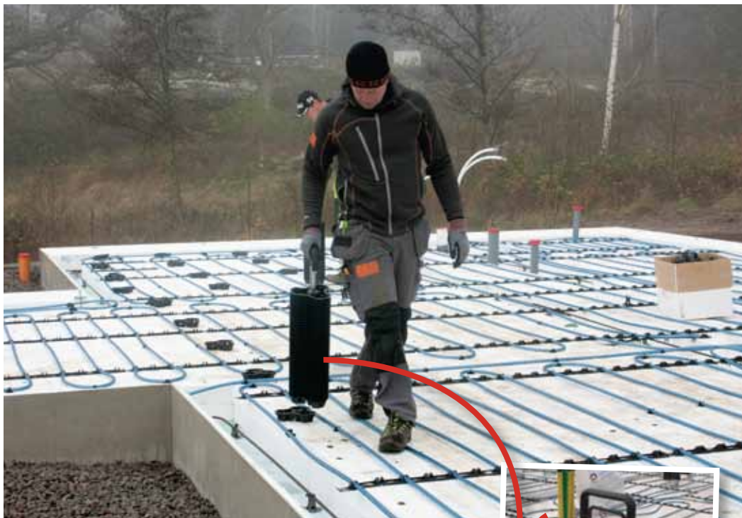
Anders Eriksson lägger ut armeringsstöden med hjälp av en krycka. I bakgrunden skymtar Rickard Brännvik.
