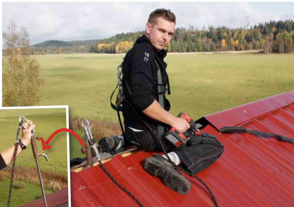
Snickaren Jonas Paulsson sitter säker på taket tack vare en rörlig krok. Den placeras över takstolen och låses fast. Uptill finns en ögla för att fästa säkerhetslinan.
