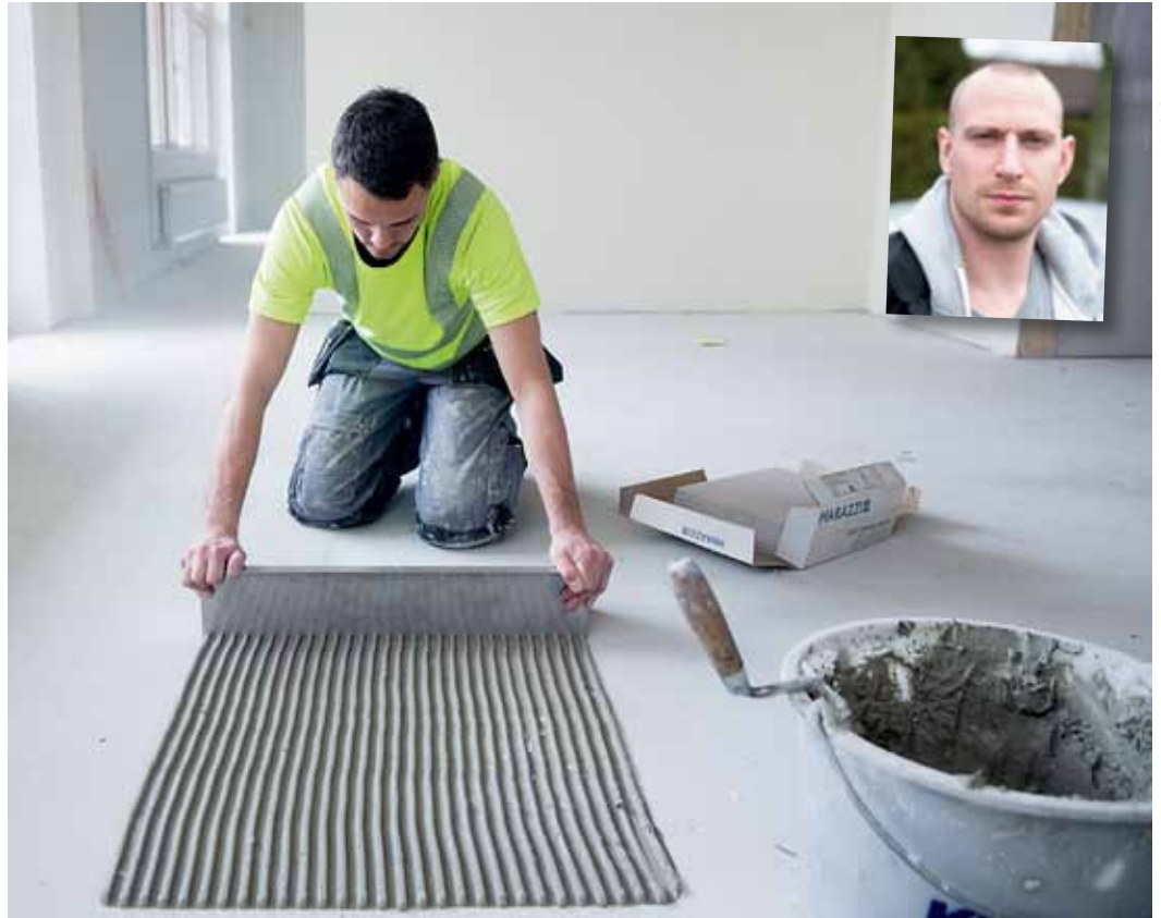
Fredrik Ljungströms (infälld) fixkam är u-formad och påminner om en skyddsplåt för spisar. De båda ytterkanterna är böjda inåt så att verktyget inte fastnar i plattraden intill.
