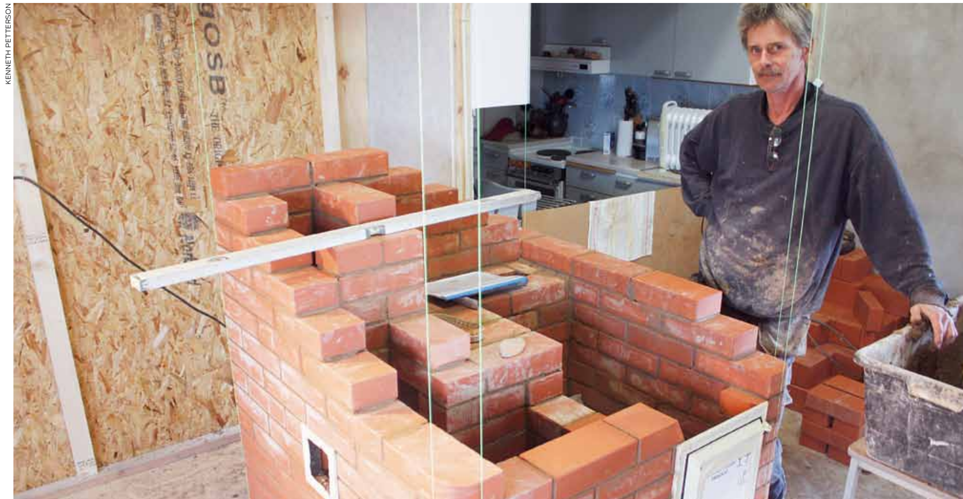
Peter Östberg-Pavlova visar den unika murkonstruktionen som ger turboeffekt i förbränningen.
