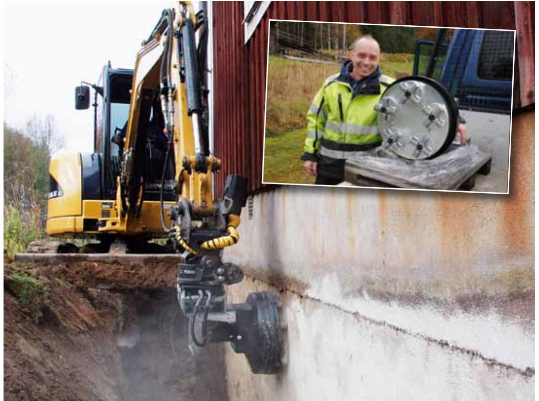
Här behandlar den nya ytfräsen en vägg till ett hus utanför Falun. På den mindre bilden syns Tomas Johansson med den roterande plattan med metalltrissor.
