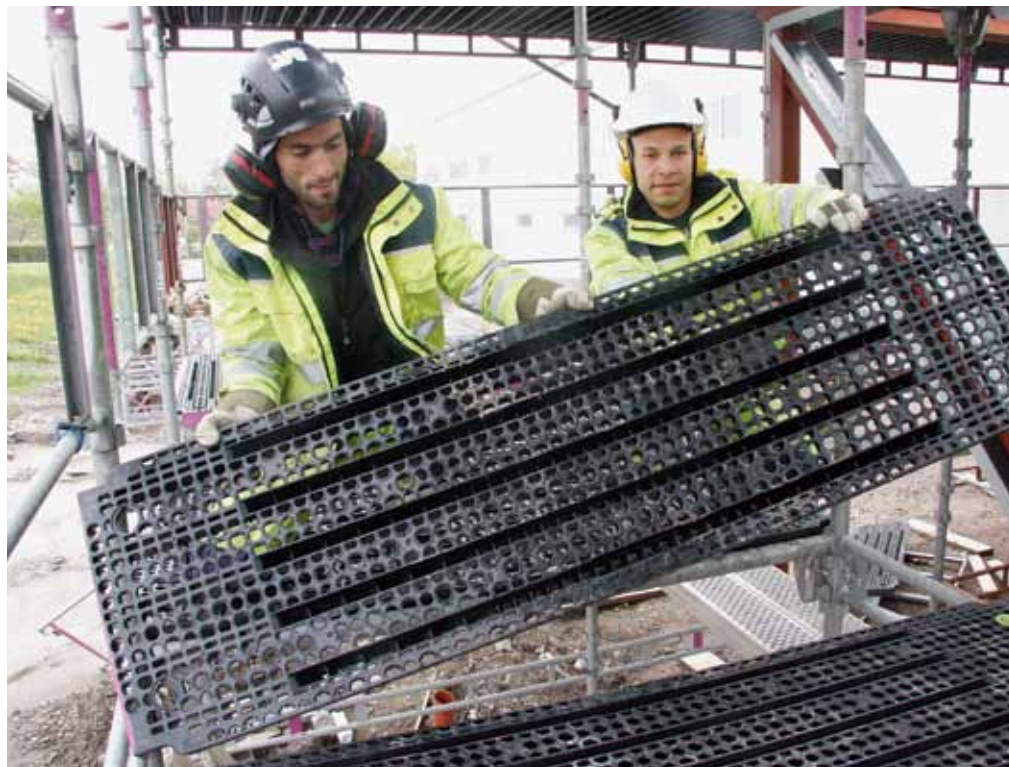
Ställningsbyggarna Borim Sherifi och Edwin Higuera får lättare lyft med den nya plasttrallen.
