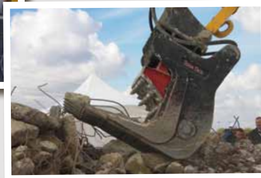
Krosskopan ValueTech från franska RDS France krossar rivningsmassorna direkt i skopan.
