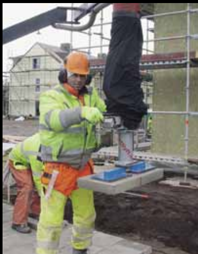
Vakuumsugen klarar av tunga markstenar.
