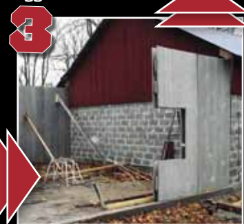
3 Därefter sätts väggen upp och fylls med betong.
