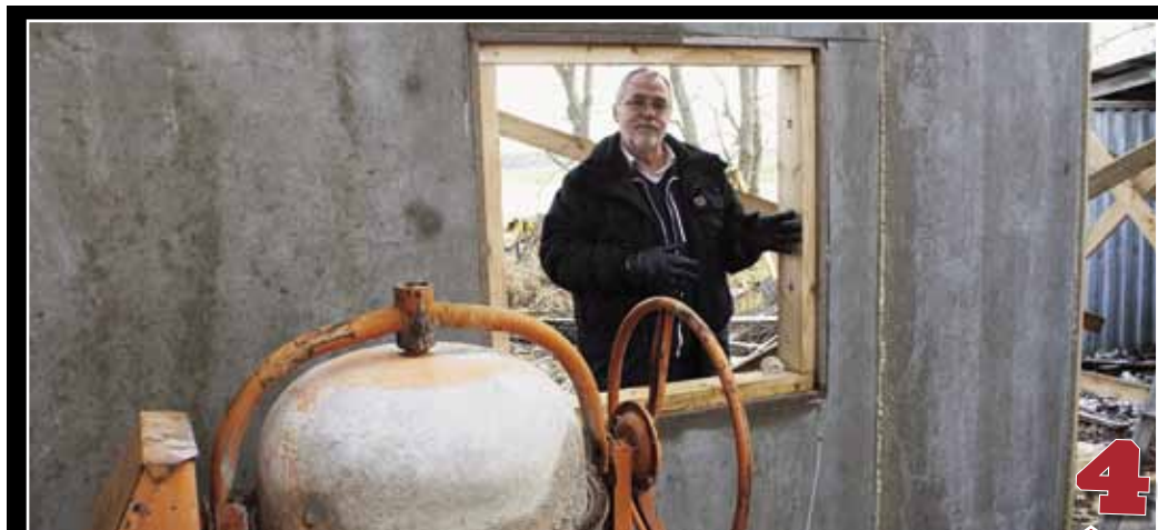
Med Kjäll Sönnergrens metod står gjutformen kvar och blir till ett väggskal.
