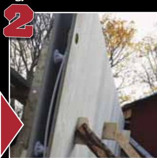
2 Hylsorna fästs i varandra och gör att väggen håller ihop.
