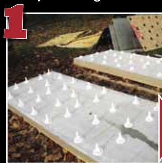
1 Distanshylsorna sätts fast på de två vägghalvorna.
