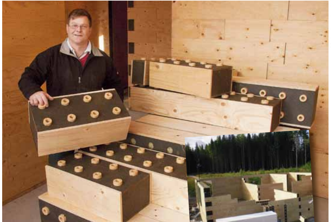
Per Hobro berättar att man på tre dagar kan få ett hus isolerat och klart med hans legometod.
