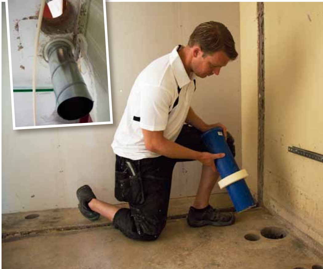
Andreas Uppgrens uppfinning gör att röret centreras automatiskt när det träs in i hålet i valvet. Den hindrar också betong från att rinna igenom när hålet runt röret i valvet senare gjuts igen.
