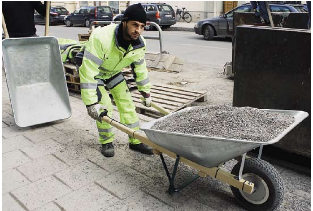
Den batteridrivna navmotorn klarar att driva en kärra med 150 kilos last.
