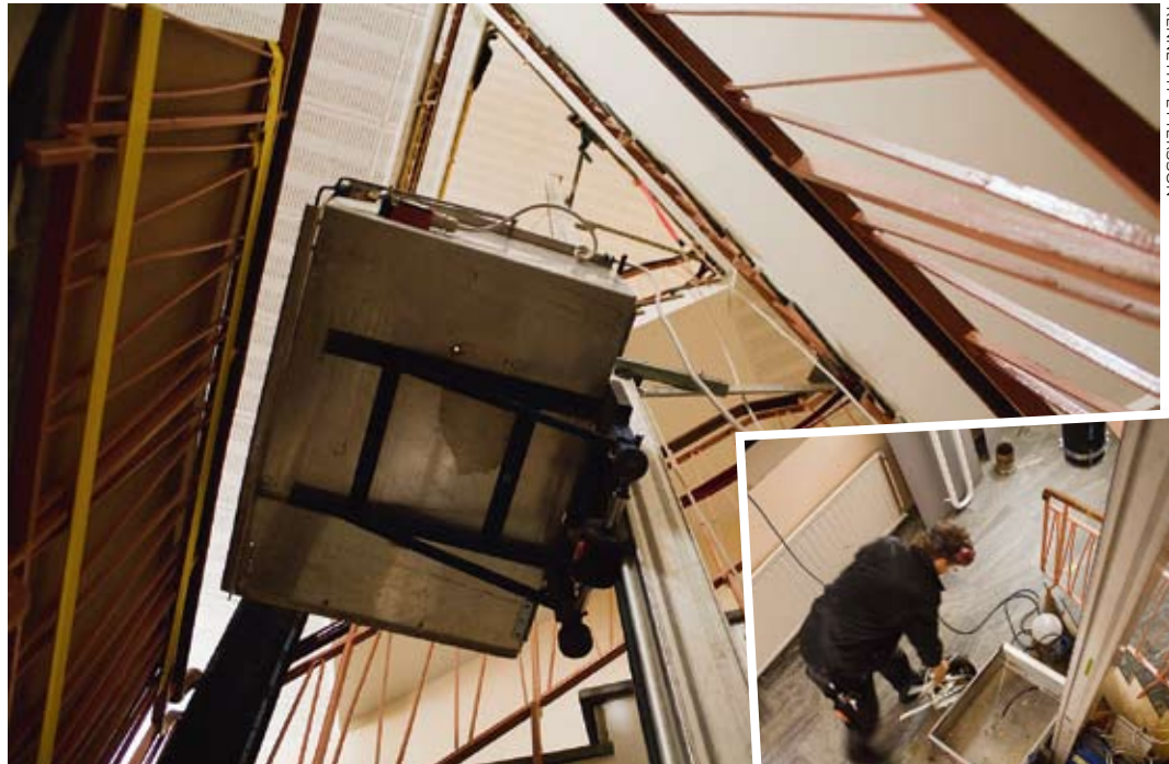
Lyften består av en aluminiumprofil som sätts ihop i sektioner. Upp till 12 meter kan den bli.
