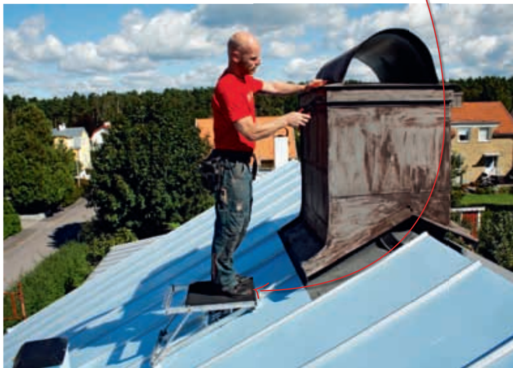
En ny plattform gör plåtslagarnas vardag lättare. Knän och hälsenor utsätts för mindre påfrestningar. (Arbetsplatsen på bilden har fasta skyddsräcken. Plattformen ersätter inte personligt fallskydd.)
