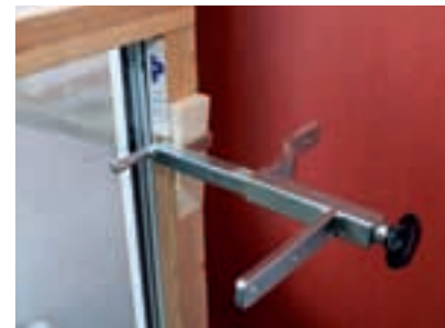
Tvingen placeras i fönstrets översta karmhål och spänns fast med en träkil.
