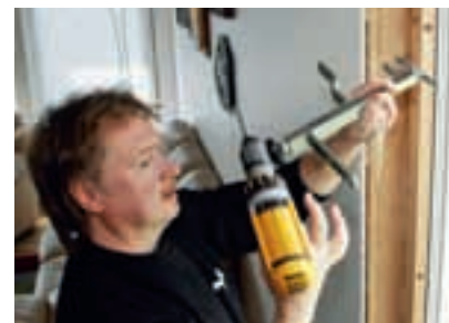
När fönstret fixerats lossas verktygen och de övre karmskruvarna monteras.
